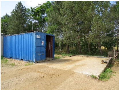
Local de stockage de GNR et aire étanche
